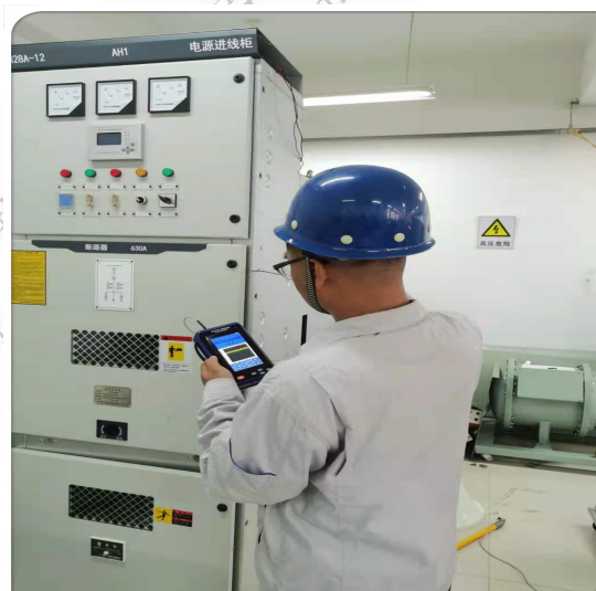
开关柜非接触超声检测
